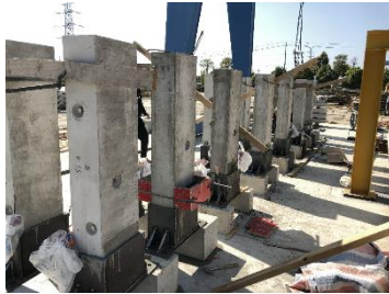
(d) Precast beam assembly
